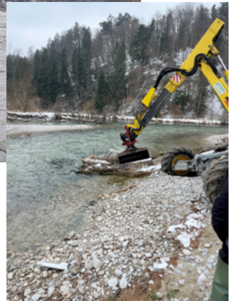
Baggararbeiten für den Ausbau der Fahrrinne für Freizeitfloße an der Isar im Naturschutzgebiet der Pupplinger Au.
