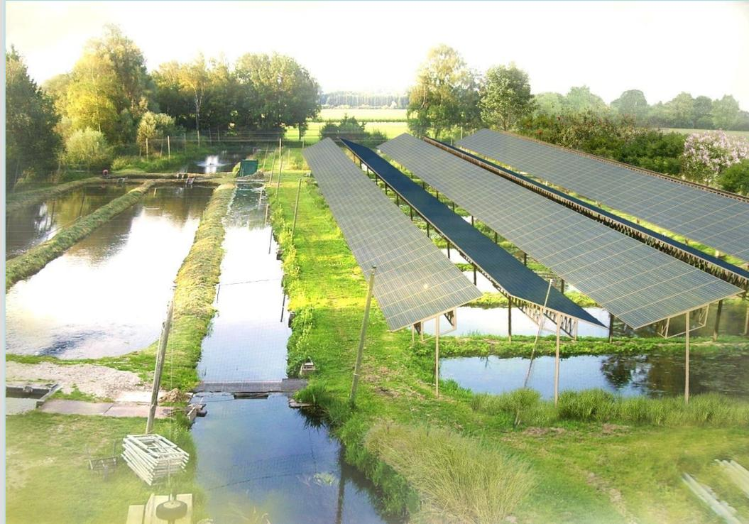
„win – win“ Maßnahme – Überdachungen mit PV-Anlagen von Forellen-Fließkanälen
